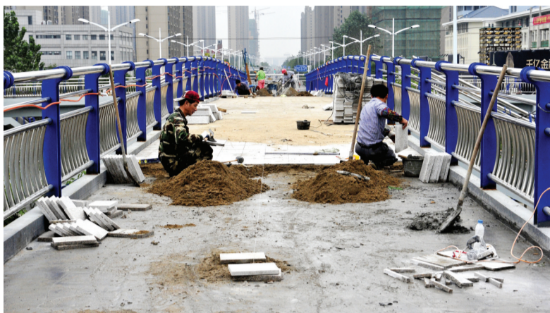
合肥洞庭湖路跨徽州大道新添一座人行天桥,同时配有BRT车站和电梯,预计10月份将投入使用。该天桥长86.8米,主桥宽4米,采用连续钢箱梁的结构形式,目前,天桥主体结构已完成,正在进行附属设施安装及桥面铺装。 记者 倪路/图
