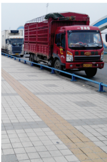
唐桥停车场附近的当涂路桥上依然违规停放着一排大货车
