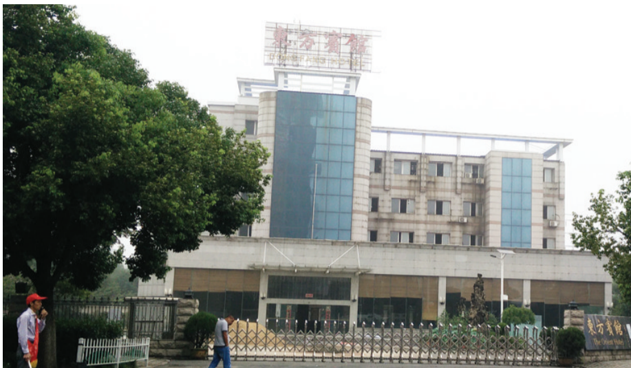
正在改造中的东方宾馆
