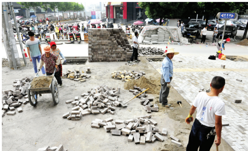
为加大路网建设,方便市民出行,近日,合肥市瑶海区对淮吾路进行改造重建。昨日,记者在现场看到,施工人员正在进行雨水管道及人行道的铺设,预计8月25日改造工程将全部完工。 记者 倪路/图
