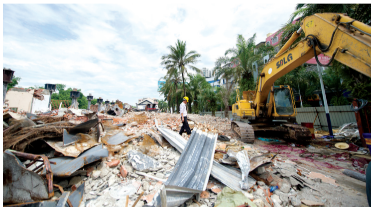
施工人员对第一批协议拆迁的房屋进行拆除
