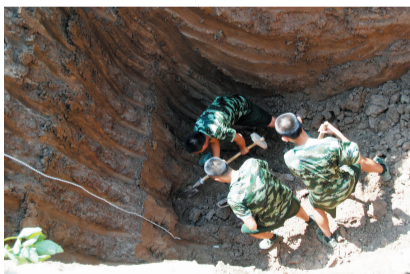
救援人员正在横向挖洞
