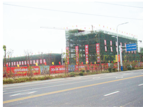
国强金属·建材城正在施工中
