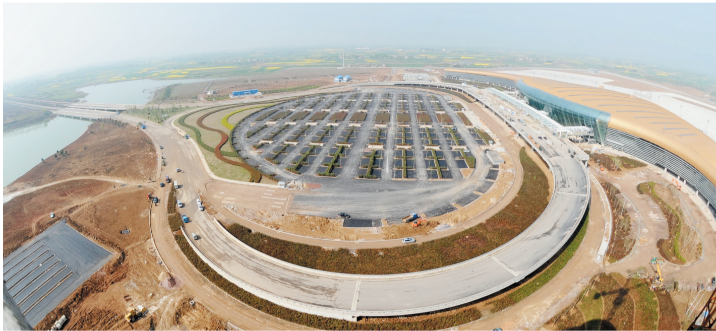
建设中的新桥机场
