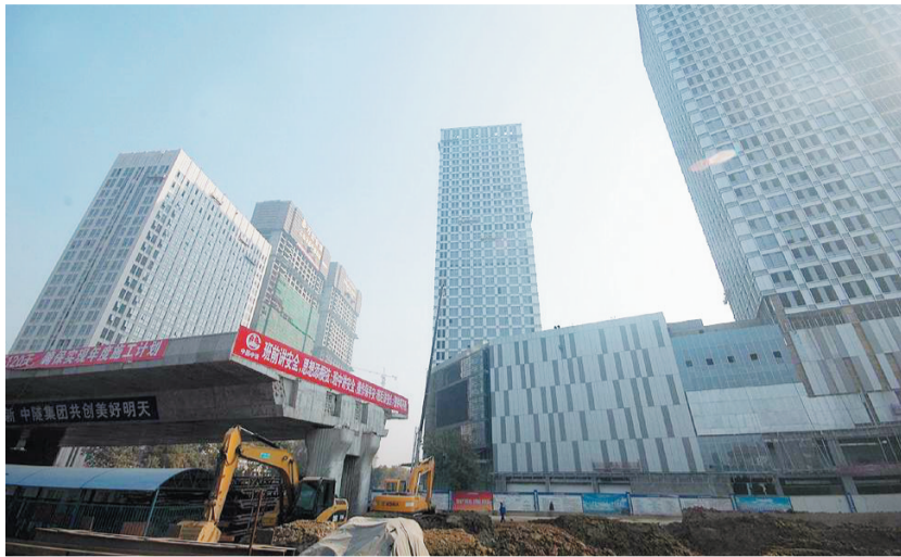
施工中的合肥地铁一号线芜湖路站(资料图片)
