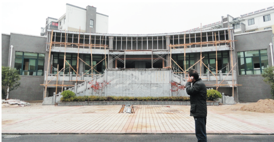
正在施工的娱乐场所
