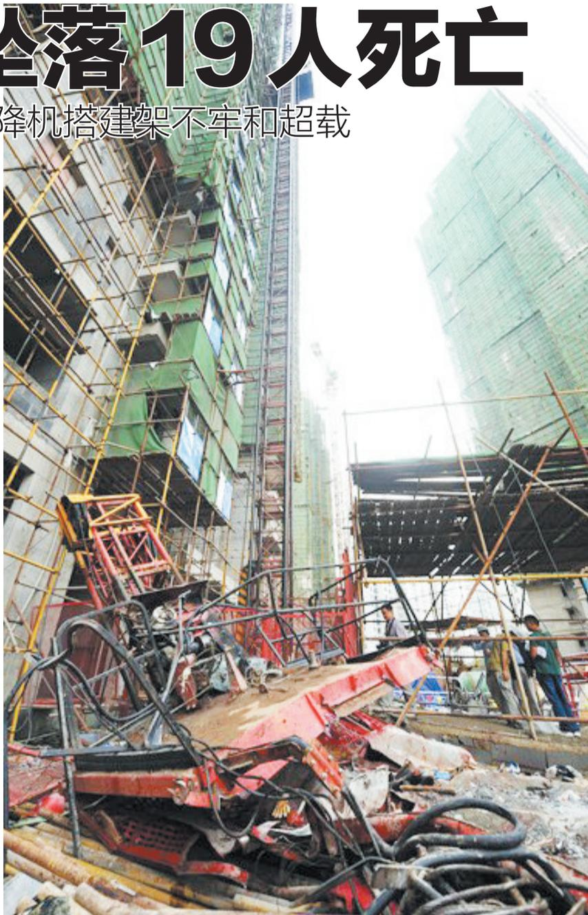
铁制梯笼已完全散架
