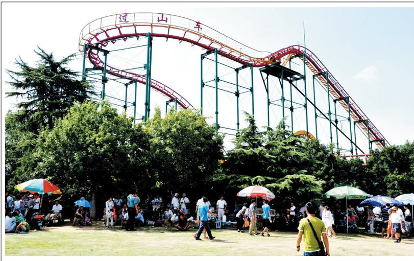
合肥唯一的过山车在花冲公园闲置好几年了,最近又重新被刷成红、黄、绿三种颜色,格外引人注目。这台过山车轨道长498米,高24米,最大时速75公里。据悉,目前已通过中国特种设备检测研究院的安全检测,它将再度运行起来。
