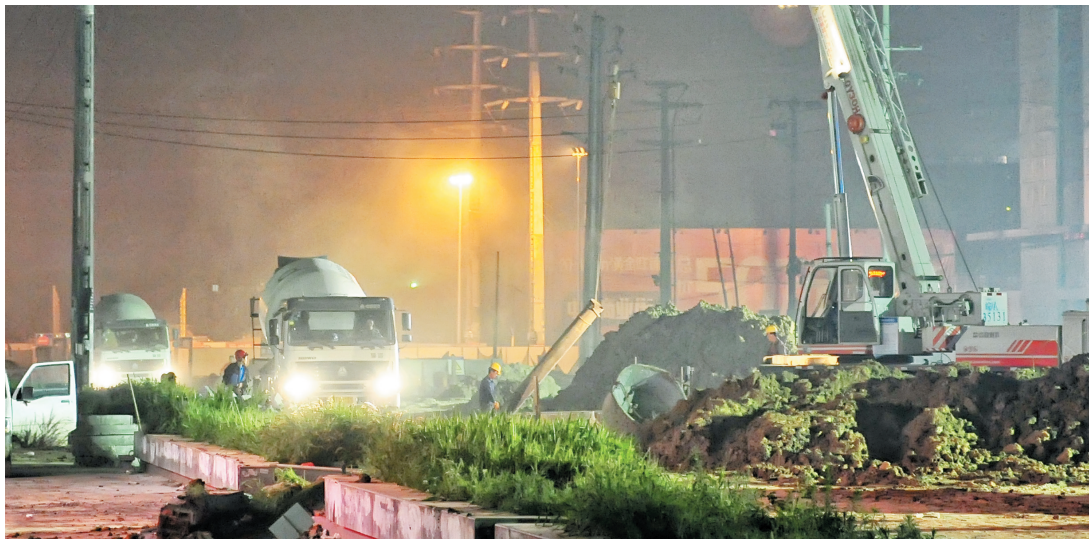
现场进出的施工车辆
