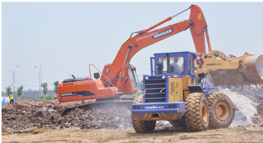
池州半导体产业园施工现场
