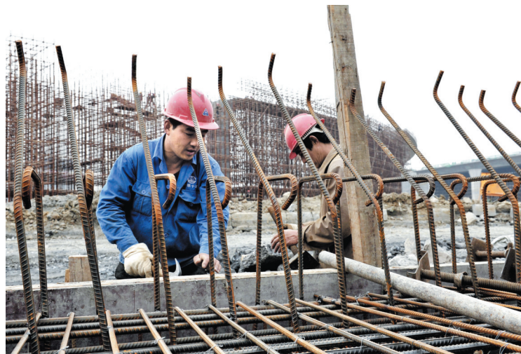
目前,合肥最短的高架徽州大道高架桥已初见雏形,计划2012年10月1日竣工。徽州大道与高铁南站衔接工程,全长3.45公里,其中高架桥部分仅2.23公里,它是一座四层互通式大型立交,共有七个匝道在此上下。 倪路 黄洋洋/摄
