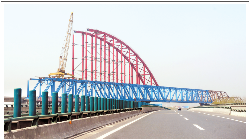
合肥铁路枢纽南环线南淝河特大桥,是合肥铁路枢纽南环线重点工程之一。在去年9月6日顺利跨越合宁高速后,目前已进入柔性拱施工阶段。记者在现场看到,这座“彩虹桥”柔性拱施工已完成一半,大桥雄姿初现。而作为南环线上横跨合宁高速的另一座大桥,经开区特大桥已经在今年2月合龙。 记者 黄洋洋 文/图
