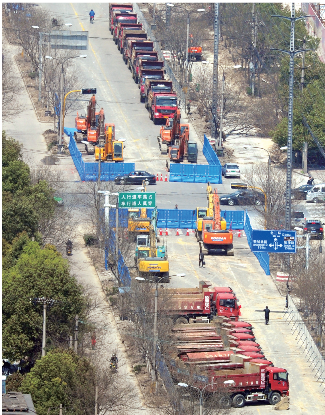
昨日上午，备受合肥市民关注的阜阳北路高架桥正式开建。记者在现场发现沿线封闭围挡已经安装完毕，施工人员和大型施工机械基本就位，建设沿线已是一片热火朝天的景象。据了解，阜阳北路高架工程北起东方大道，南至沿河路，全长9.3公里，其中高架路段约9.01公里，号称“最长高架”。建成后，将大大改变“肠梗阻”现象。 记者 黄洋洋/图
