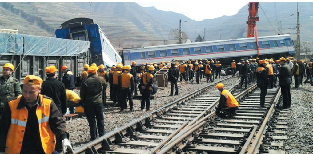
列车脱轨施救现场
