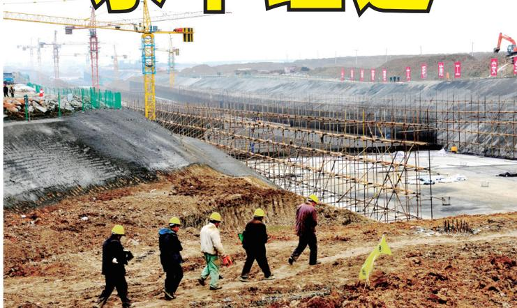
目前,合肥首条穿湖隧道在紧张建设中,计划2012年底通车。方兴大道(包河大道至福建路段)将从方兴湖底穿过的路,是合肥市第一条湖底隧道,长度为820米,双向八车道。
