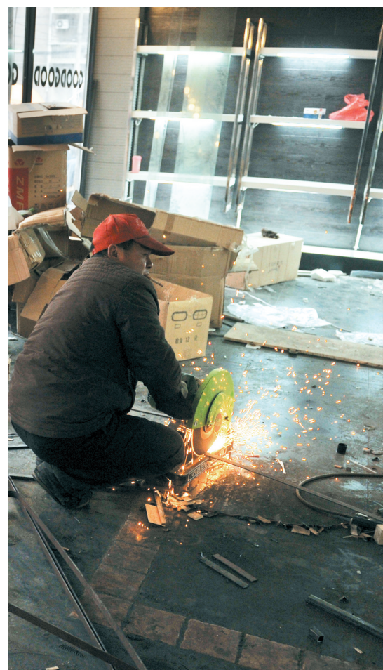
趁着女人街封闭改造,部分商家已经开始着手店内的重新装修。
