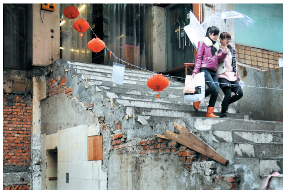
女人街太阳城店外的电梯已经拆除
