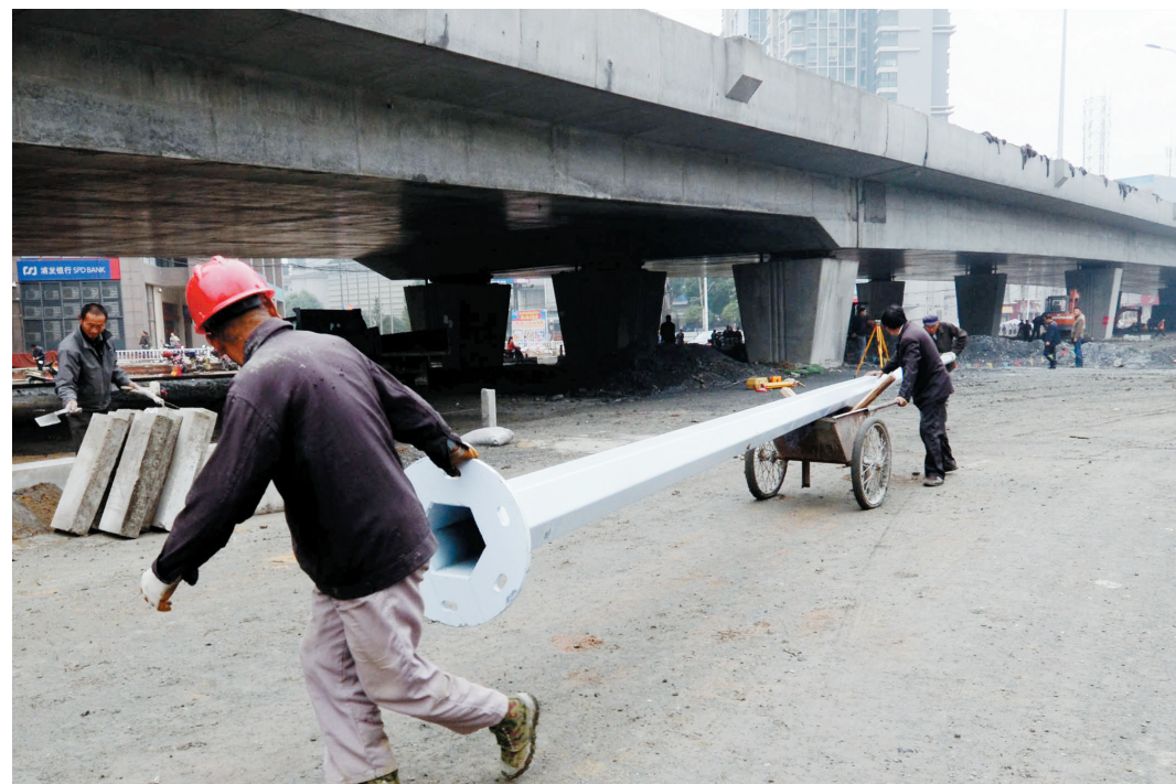
畅通一环胜利路桥下,工人正在紧张地施工
