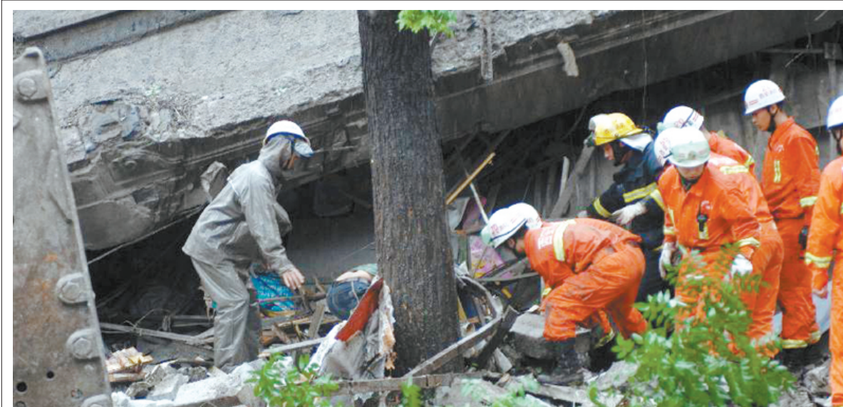
11日10时许,西安市东大街端履门十字路口华侨商店突发墙面坍塌事故。截至昨日14时许,现场救援工作已经结束,事故共造成2人死亡,2人受伤。另据了解,10日上午该市一工地施工脚手架坠落,造成10人死亡。 新华社发
