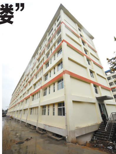
即将完工的“陪读楼”
