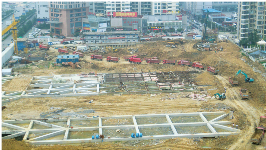
钻入操作平台下的挖土作业
