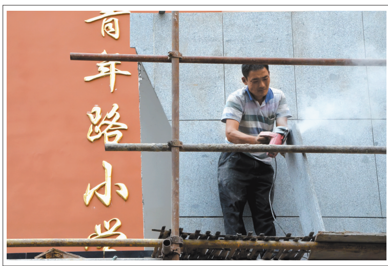
为顺利迎接9月1日的新生开学,8月21日,一名工人在合肥市青年路小学“校安工程”施工现场进行门头改造施工。据了解,目前学校内部教学楼改造工程已完成,现进入尾声阶段。 记者 程兆文/图
