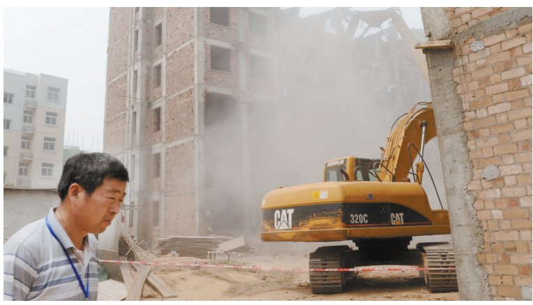
刚封顶的拆迁安置房正在被拆除
