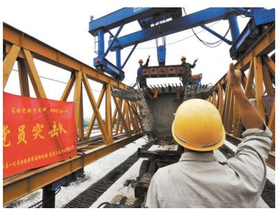
6月22日,合肥新桥机场合六叶高速互通立交桥上,工作人员在吊装立交桥横跨桥梁。据了解,新桥机场高速连接合六叶高速互通立交预计七月底全面放行通车。 陈林 记者 程兆/图
