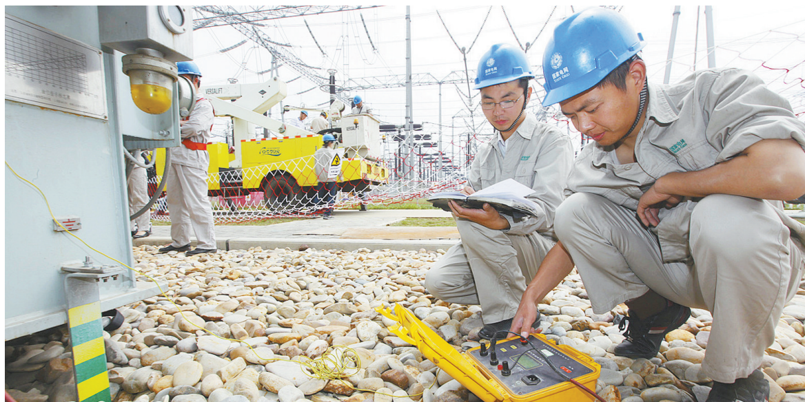
5月26日,技术人员对当涂变电站的两台总变电容量为1500兆伏安主变压器进行升级、维护,应对电力紧张局面
