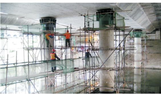
星报讯(邓业锋记者徐涛文/图) 昨日上午,记者从 合肥市北二环跨板桥河桥支座更换工程现场获悉,目前施 工人员正在用千斤顶将桥体整体抬升,并同时为40个桥台 支座进行更换,预计有望下月底完成。届时,该桥将告别重 车通过时上下跳动、左右摇摆明显的"病痛"和安全隐患。
