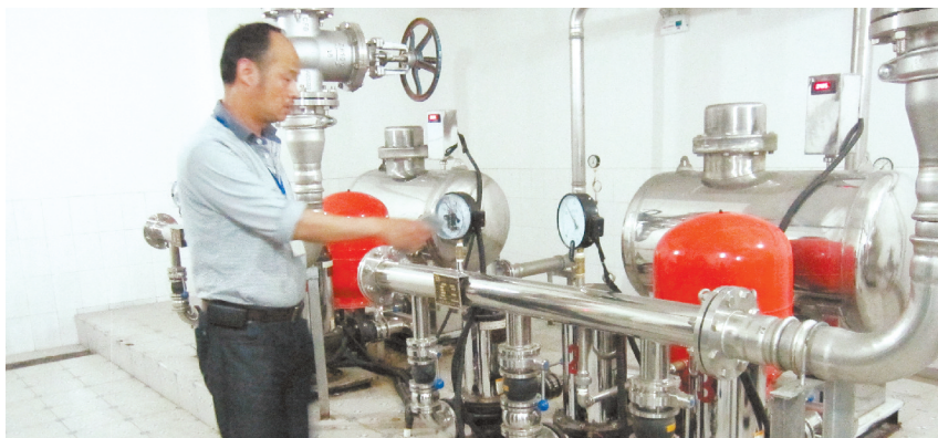
范光辉检查泵房
