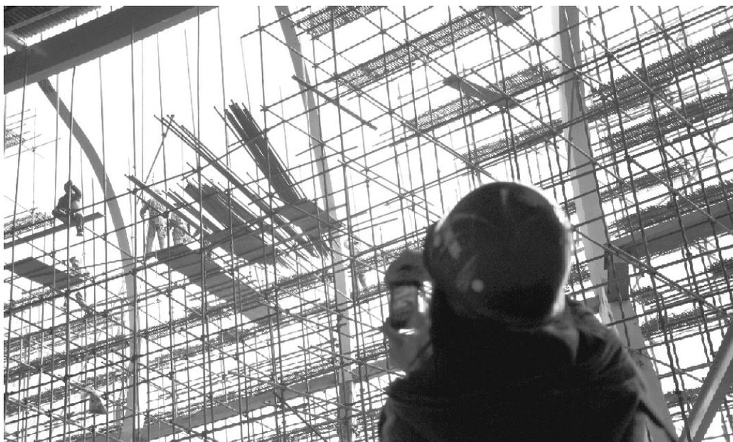
昨日,合肥新桥国际机场施工现场,工人正在进行玻璃幕墙装配作业。据了解,整个航站楼使用的玻璃材料既能满足采光,还能起到保温的作用。目前装配进度已过大半,预计墙体施工可在年底结束。黄洋洋 记者 李超钰 文/图
