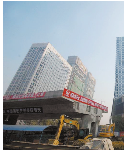
马鞍山路正在建设的高架
