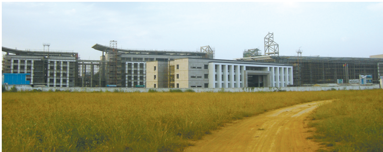
正在装修的大楼
