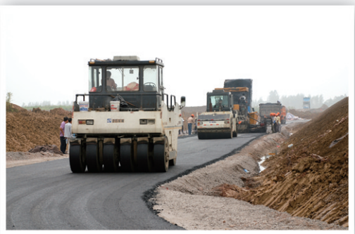
巡场路正在 摊铺沥青
