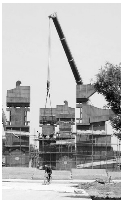
大明宫遗址公园建成建筑遭拆除
