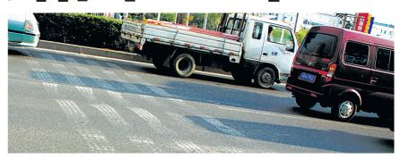
路面也结实得多,但知损坏得更快。原因 就是西二环上经过的大型货车少,而南二环 上经过的大型货车多。"
