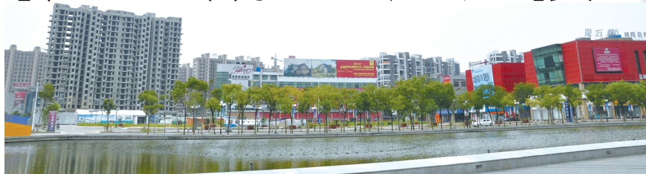
“烂尾楼”身处闹市区
