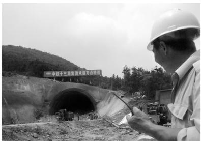
昨日,中铁十三局的建设者冒着高温在合福高铁安徽巢湖万山隧道施工。合福高铁从巢湖万山穿山而过,万山隧道长约500米,目前已经打通20多米。为了确保该隧道如期贯通,建设者们顶烈日、战高温,夜以继日加快施工进度。
