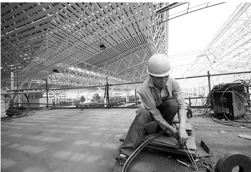
工人们正在抓紧施工
